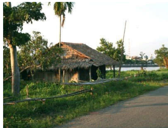
NHÀ MỘT TẦNG CHỈ CÓ TƯỜNG XÂY GẠCH BỀN CHẮC, KHÔNG CÓ CỘT, MÁI LÁ
